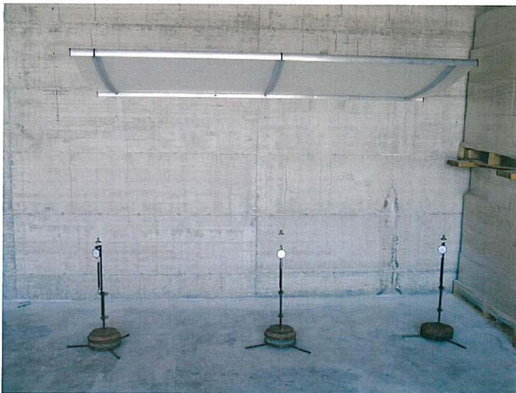
Fase 2 – Mensole all'estradosso
