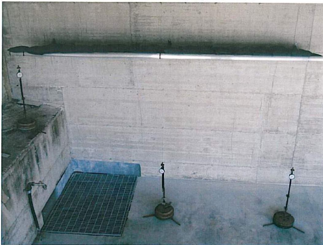
Fase 2 – Mensole all'estradosso
