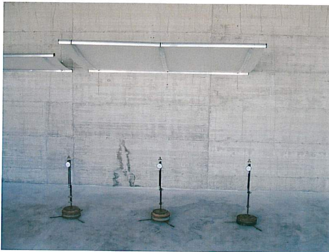
Fase 2 – Mensole all'estradosso
